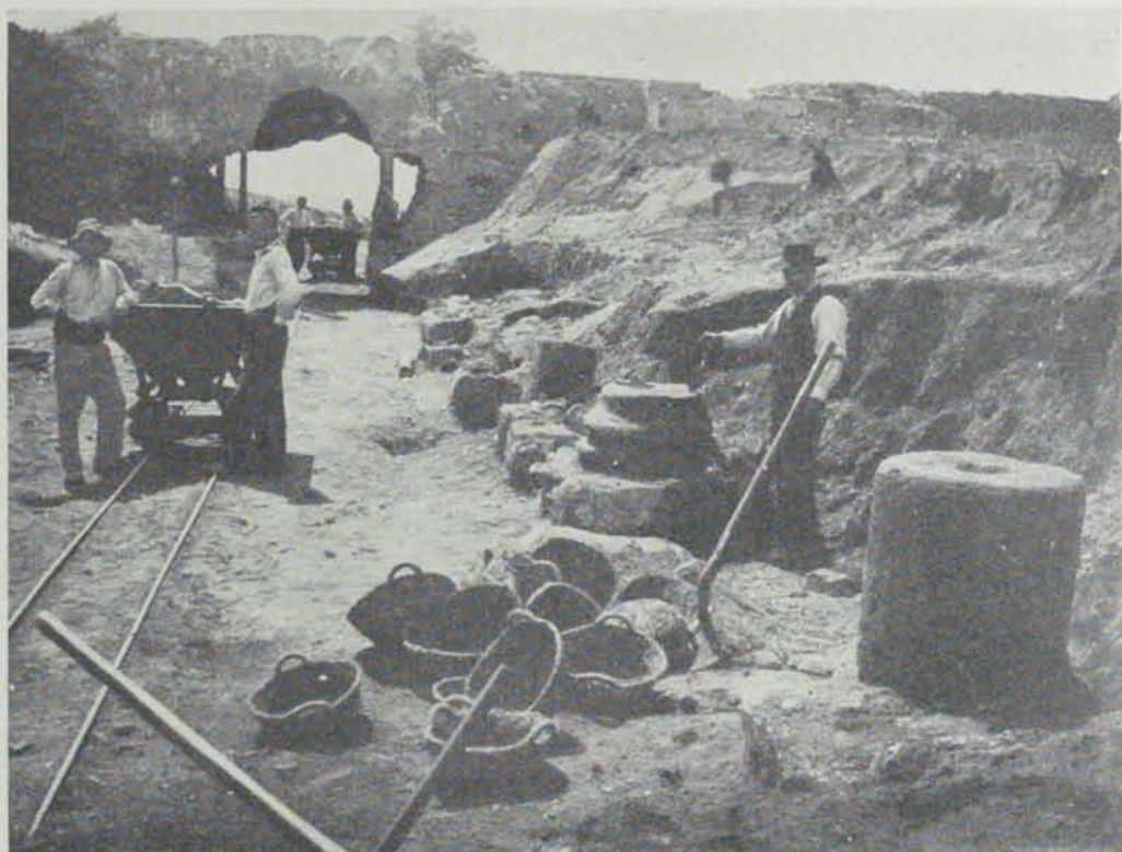
Fig. 33. — La via porticada de la ciutat romana. (Fot. Gandia)
